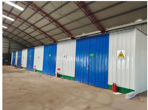
项目危废储存间
