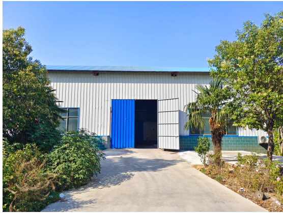
项目租用厂房现状
