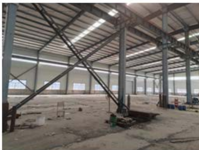
项目南侧空车间
