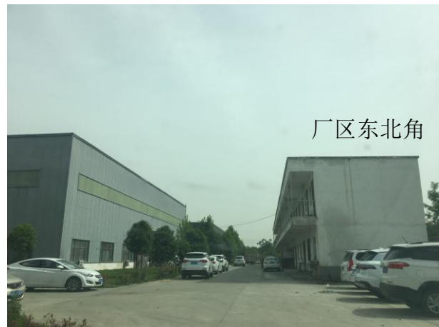
宝新实业公司厂区内部配套生活用房（右）
