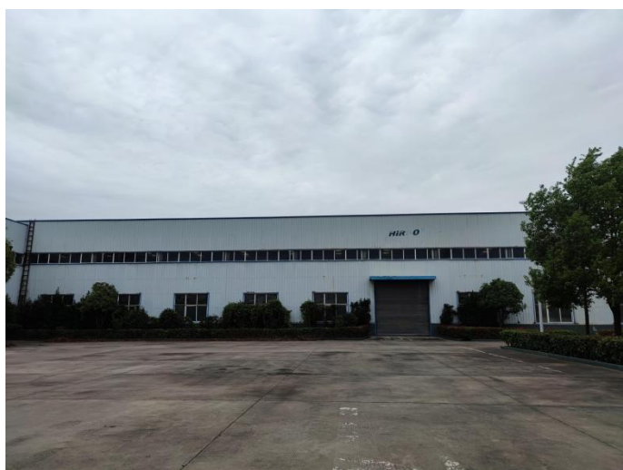
项目所用车间
