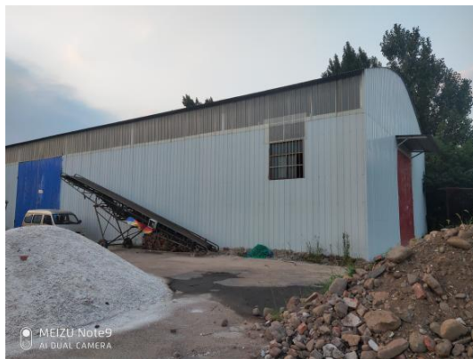
废旧电池暂存厂房
